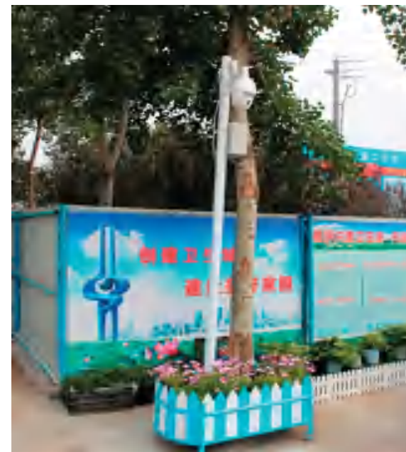
监控探头（道路）
