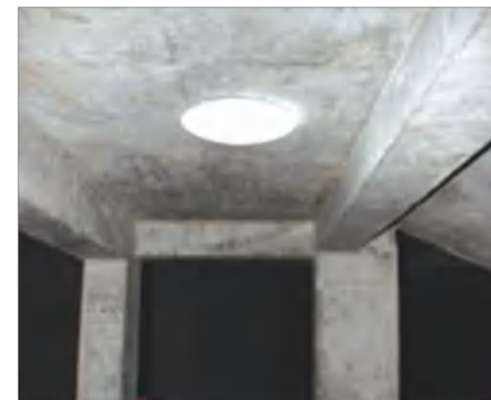
利用工程正式线路
