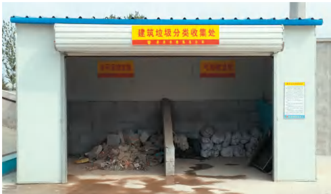
施工现场封闭式垃圾池
