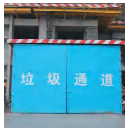
封闭式楼层垃圾收集池
