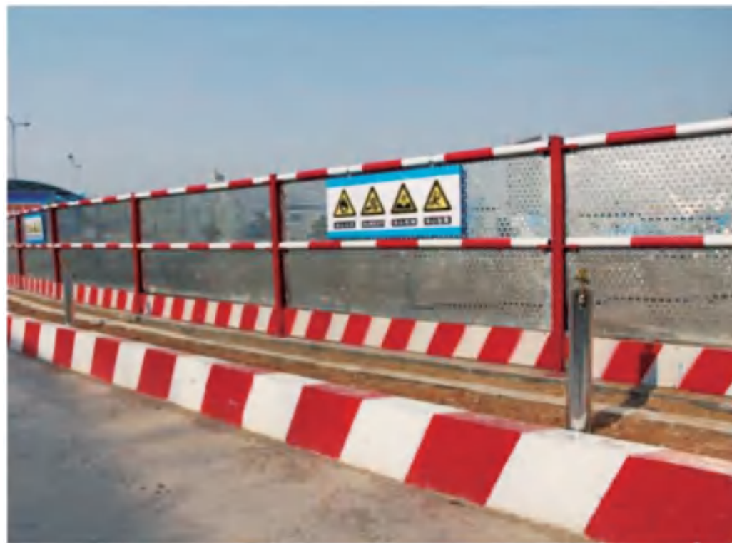
基坑临边防护（挂设钢板网片）
